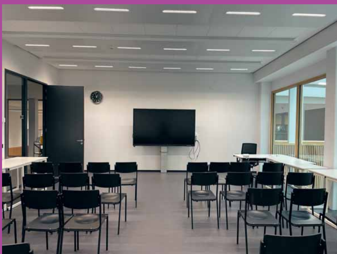
De verlichting, ook een enorme bron van energiegebruik, is uitgevoerd met een nieuw type ledarmatuur. Deze heeft een hogere lichtopbrengst bij een laag energieverbruik van minder dan 6 W/m 2 .
