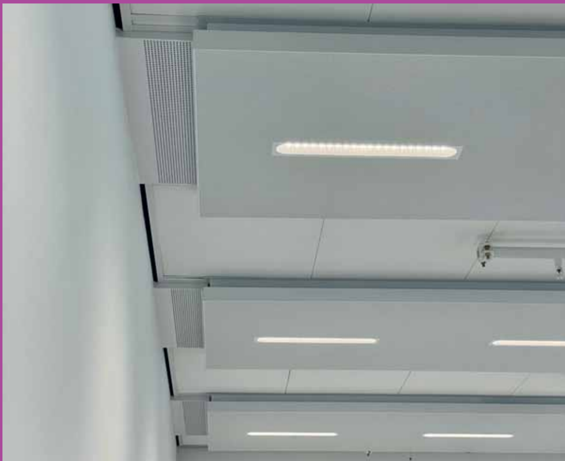
Voor luchtverversing in de onderwijsruimten is gekozen voor zogeheten hybride 'klimaateilanden'; een soort klimaatplafond waar de lucht door wordt verspreid. Die 'eilanden' hangen modulair in alle ruimten.
