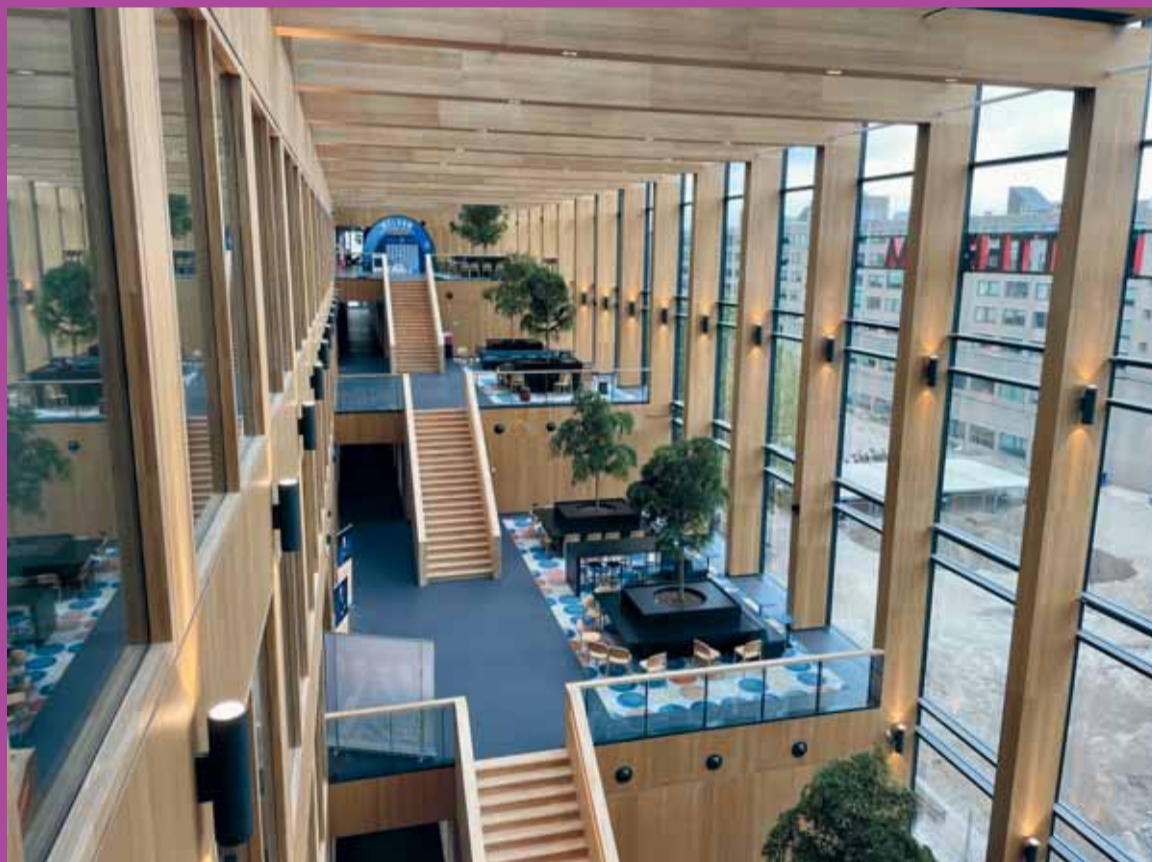
Het grote en hoge atrium wordt gebruikt om een groot deel van de toegevoerde lucht retour te halen.
